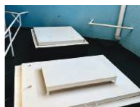
TRATAMENTO DE ÁGUA (ASTRAL)
